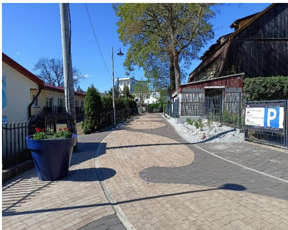
Zdj. 6.2 Przebudowana ul. Marynarska w Mrzeżynie
