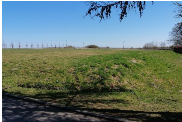
Zdj. 6.19 Przeprowadzone prace ziemne polegające na niwelacji i odpowiednim ukształtowaniu terenu pod nowe miejsca pochówku.
