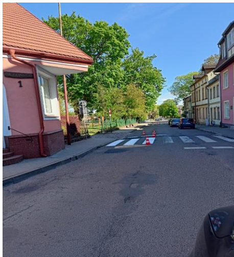
Zdj. 6.5 Malowanie oznakowania poziomego
