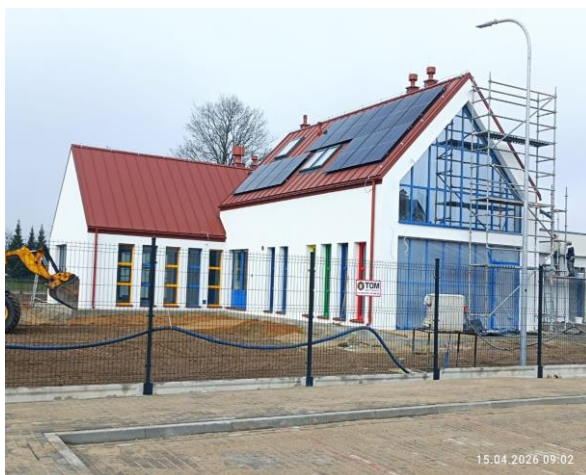
Zdj. 18.1 INWESTYCJE – Budowa żłobka w Trzebiatowie
