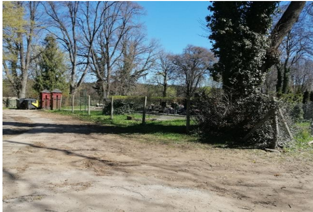
Zdj. 6.18 Naprawione uszkodzone ogrodzenie w Kłodkowie.
