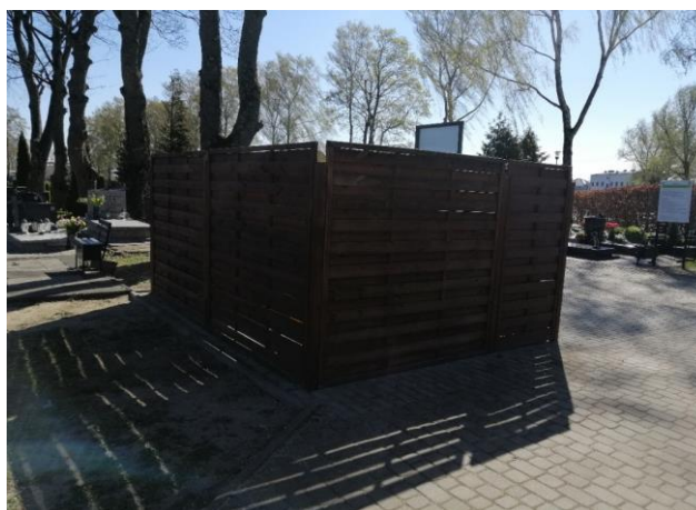
Zdj. 6.17 Naprawa zabudowy pojemników na odpady komunalne.
