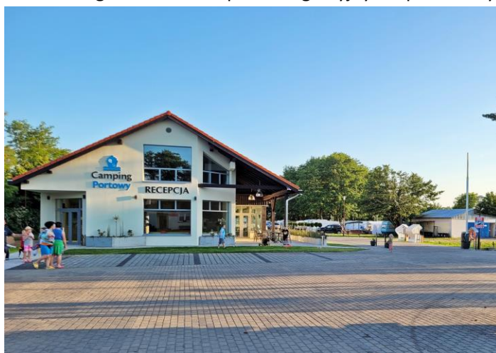
Zdj. 9.6 ZGM - Widok na budynek na Kampingu Portowym
