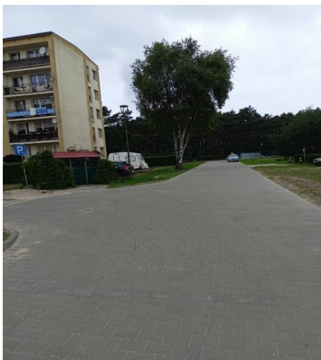
Zdj. 6.3 Przebudowana ulica w Rogowie
