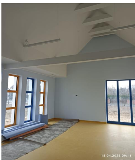
Zdj. 18.2 INWESTYCJE – Budowa żłobka w Trzebiatowie.
