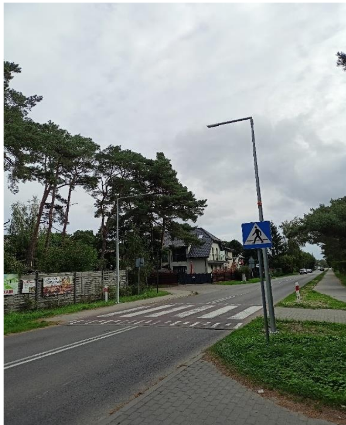
Zdj. 6.27 Doświetlenie przejścia dla pieszych w Rogowie.
