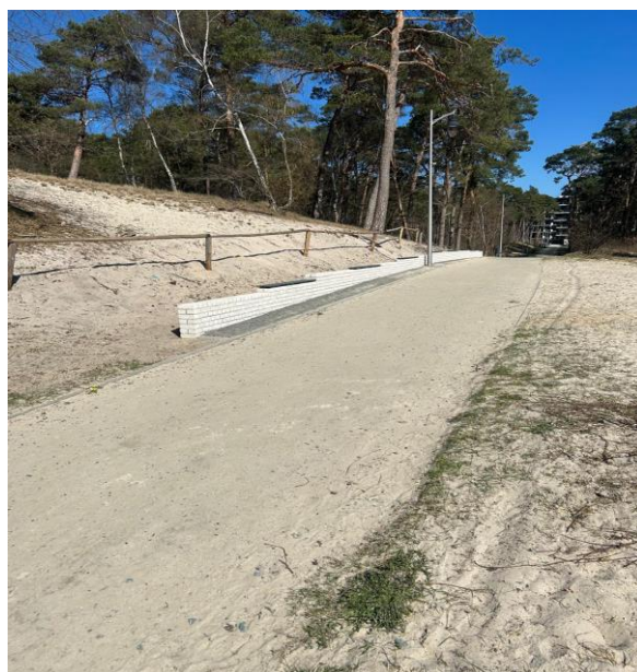
Zdj. 18.6 INWESTYCJE – Budowa murka oporowego w Mrzeżynie
