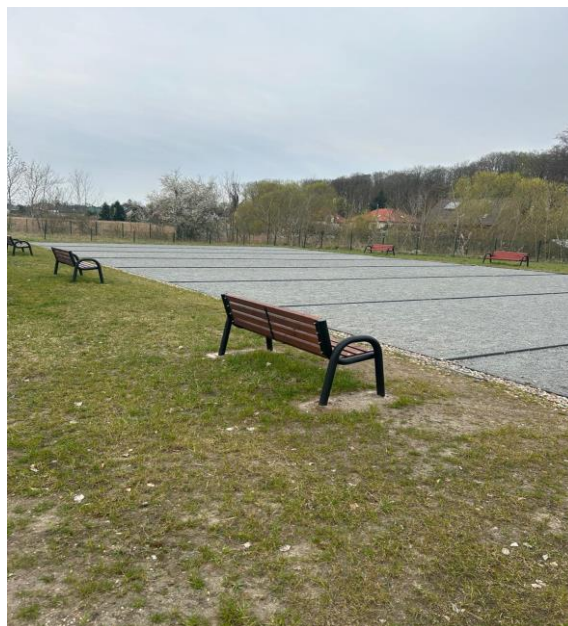
Zdj. 18.5 INWESTYCJE – Budowa boiska do gry w bule.
