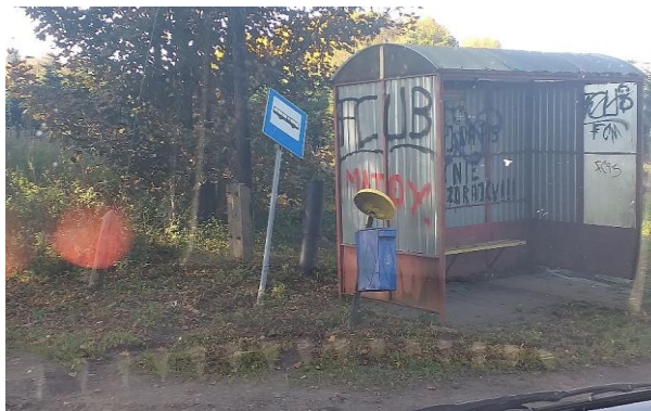
Zdj. 6.14 Zdewastowana wiata przystankowa
