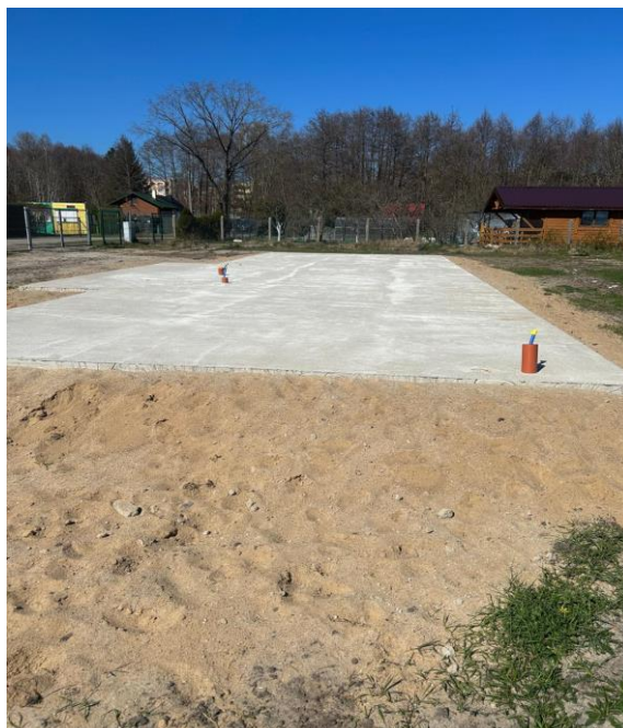
Zdj. 18.9 INWESTYCJE – Budowa zaplecza sanitarnego na terenie boiska piłkarskiego.
