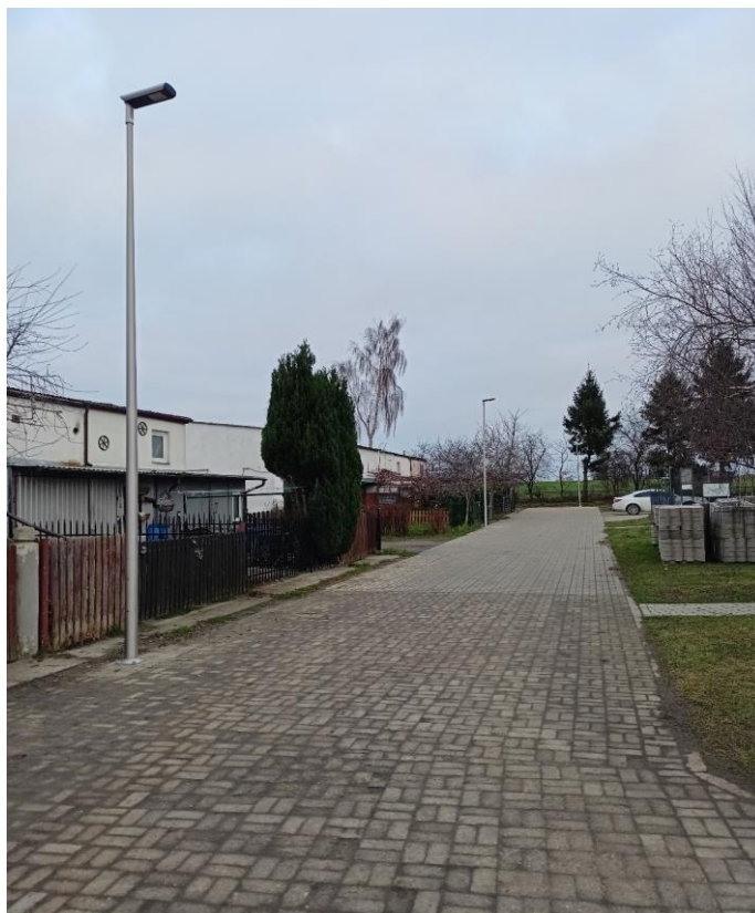
Zdj. 6.28 Budowa oświetlenia w Nowielicach
