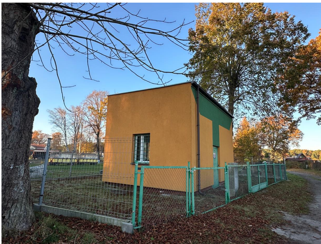
Fot. 13. Przepompownia ścieków przy ulicy Kasztanowej (G. Nordlów)
